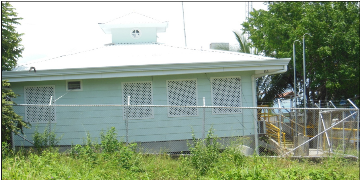
Fig. 2.4 - Capitanía Port Office in Puntarenas (9.978153° N 84.840758° W)
