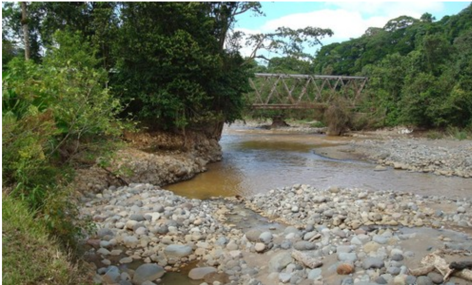
Fig. 4.27 - Bridge De Hierro Sobre El Rio Sarapiquí-La Virgen (10.38825° N 84.13859° W).
